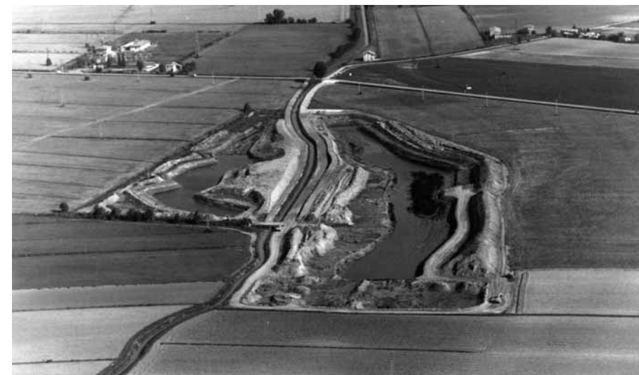
Fig. 1 - Veduta aerea dell'area in fase di ripristino.
